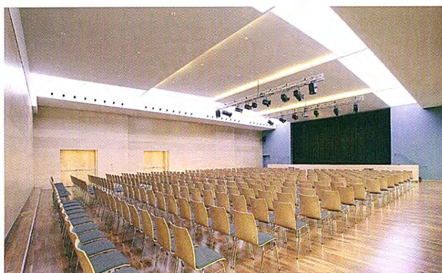
2 | Akustikelemente in Veranstaltungsräumen dienen nicht nur der Lärminderung, sondern einer guten Akustik. Längere Nachhallzeiten als bei reinen schalldämmenden Maßnahmen sind erforderlich und in ihrer Länge von der Darstellungsart abhängig.
